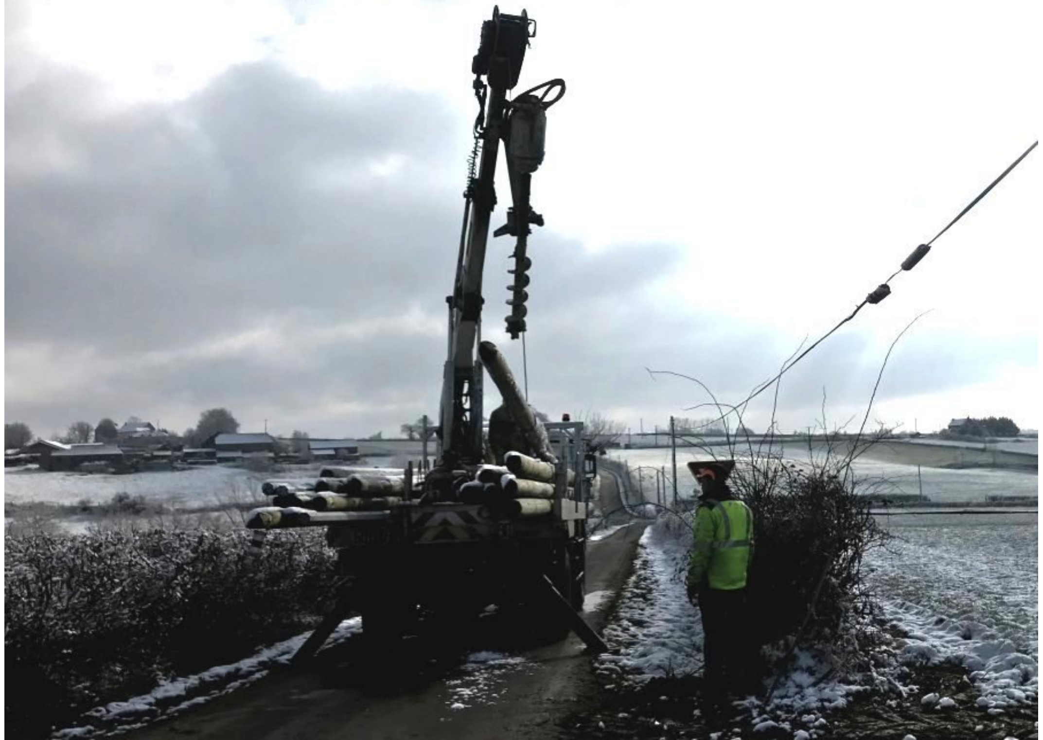
Meljac - travaux sur la ligne téléphonique par remplacement de poteau
