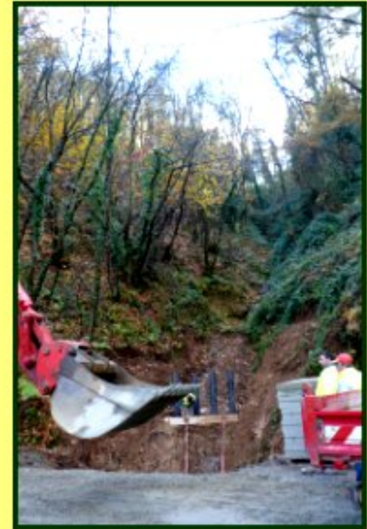
Travaux réalisés en 2008 consécutifs aux dommages de l'orage de juin 2007
