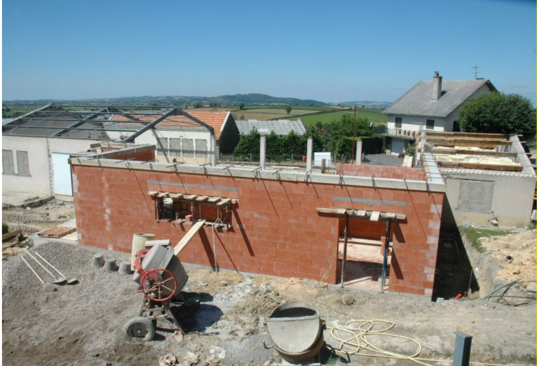
Le chantier de rénovation de la salle des fêtes de Meljac "bat son plein" ... A l'horizon, le Puech de Rouet d'où l'on peut aussi suivre le chantier meljacois.
