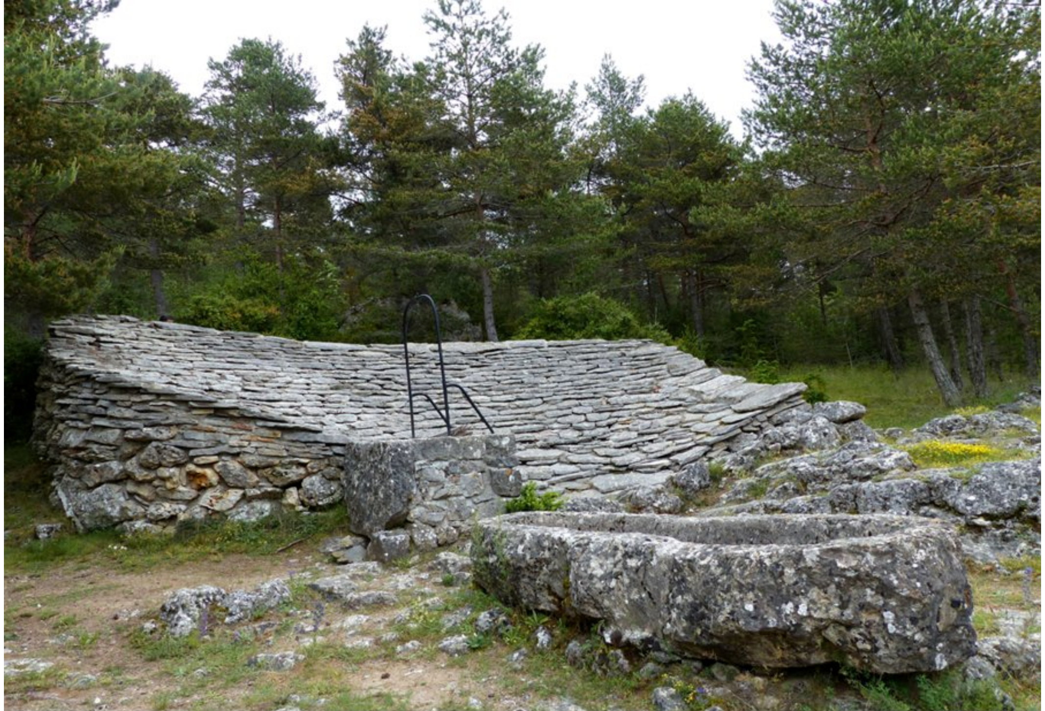
Abreuvoir sur le Causse noir: cette toiture ne sert qu'à recueillir l'eau de pluie et à l'envoyer dans la citerne creusée en dessous. l'eau est remontée avec un seau et versée dans l'auge en pierre où viennent boire les troupeaux (date probablement de plusieurs siècles)
