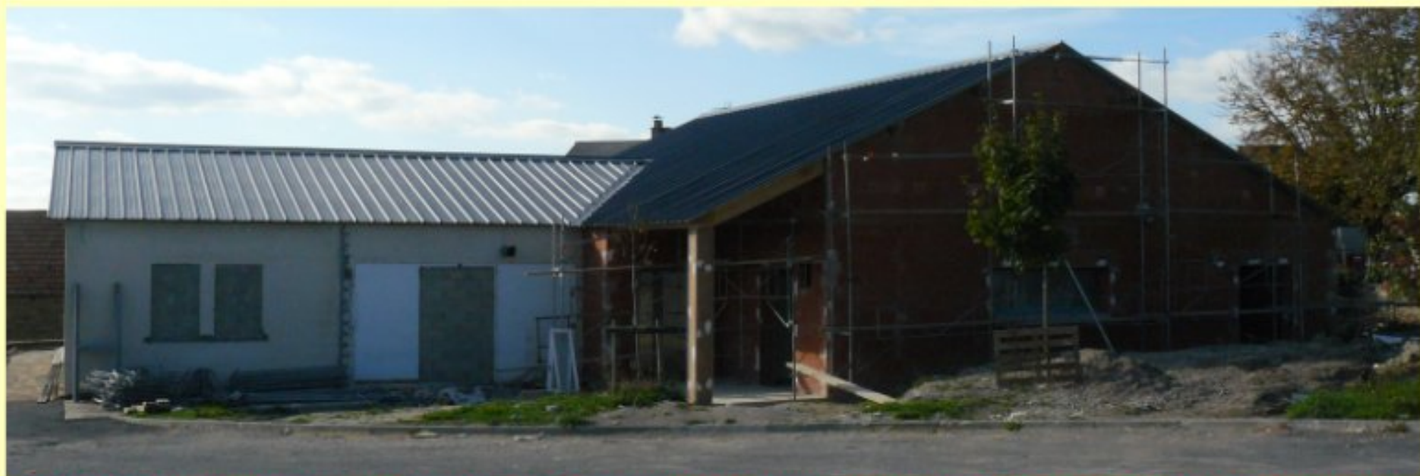
5.11.07: cela avance... et l'essentiel des travaux se déroule désormais à l'intérieur de la salle des fêtes
