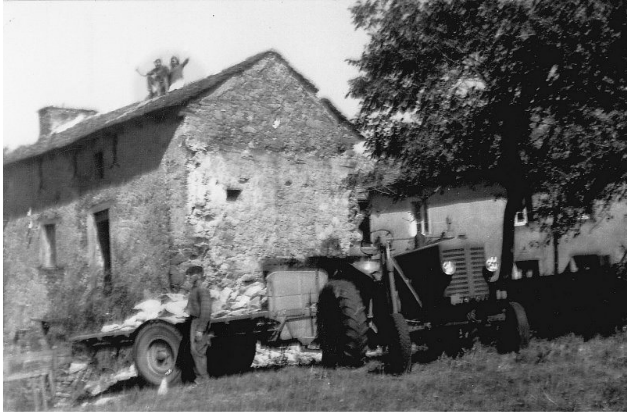
1967 démolition de la laiterie (maison de Sylvie) à La Bessière
