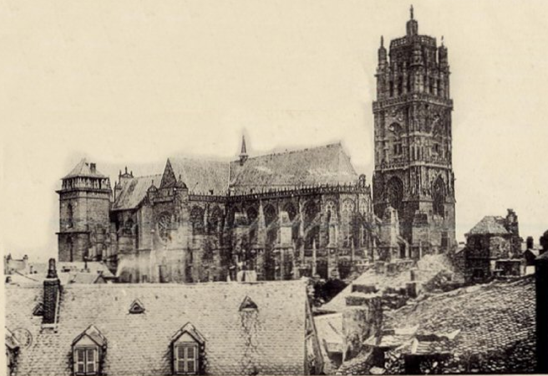
Les dernières travées furent construites sous l'Évêque de François d'Estaing (1501-1529)
