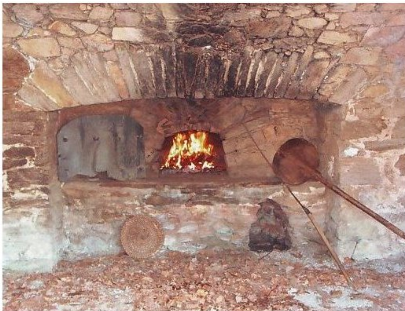
four - ferme Mazars à la Bessière
