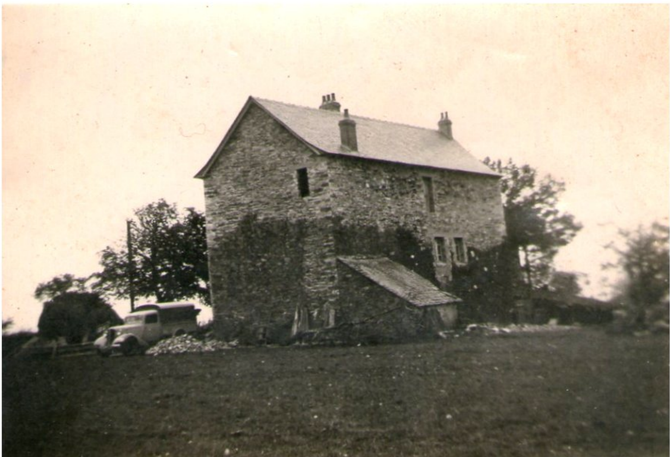
Maison AZAM - Grascazes de Meljac - pendant travaux
