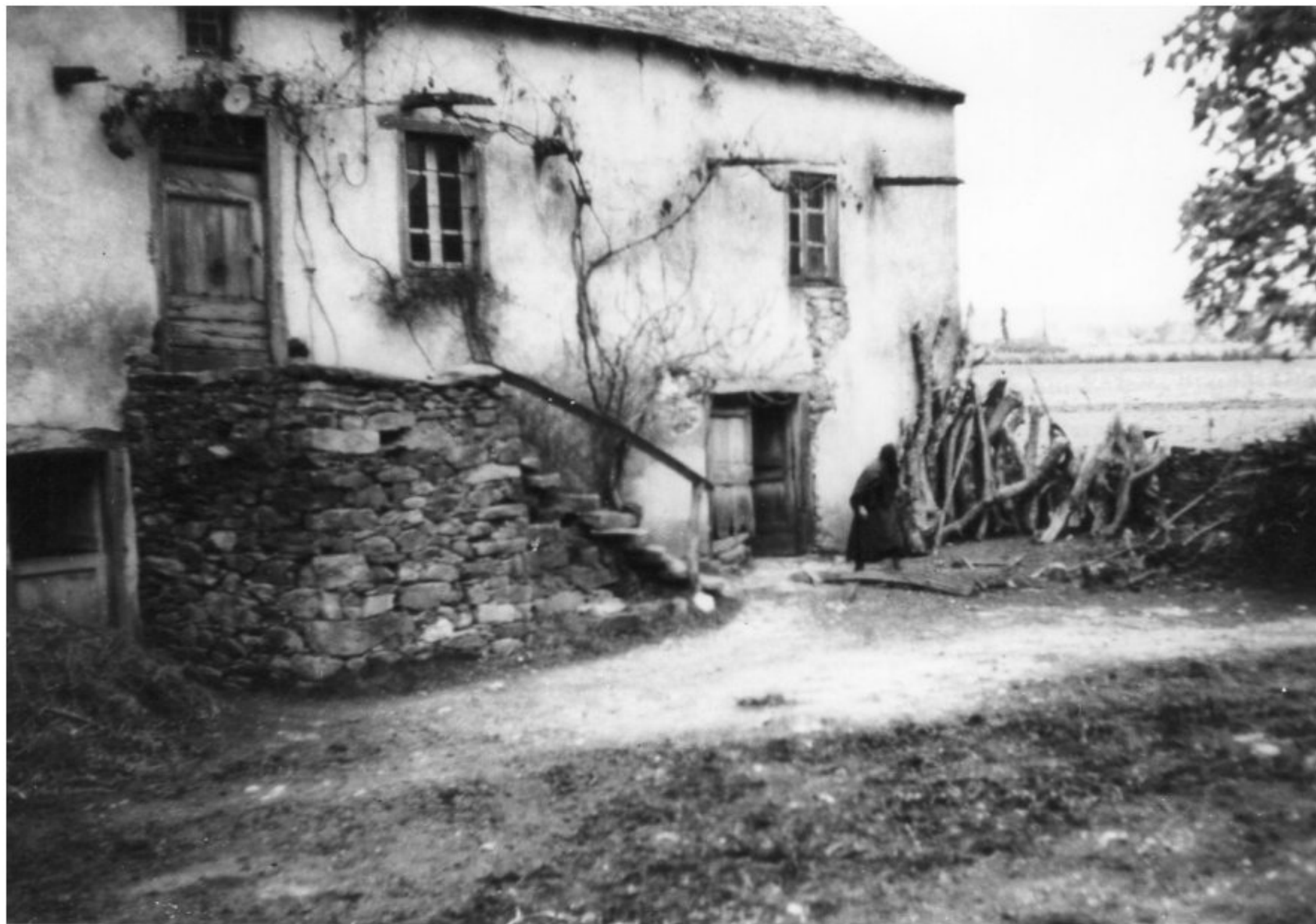
Maison AZAM - Grascazes de Meljac - avant travaux
