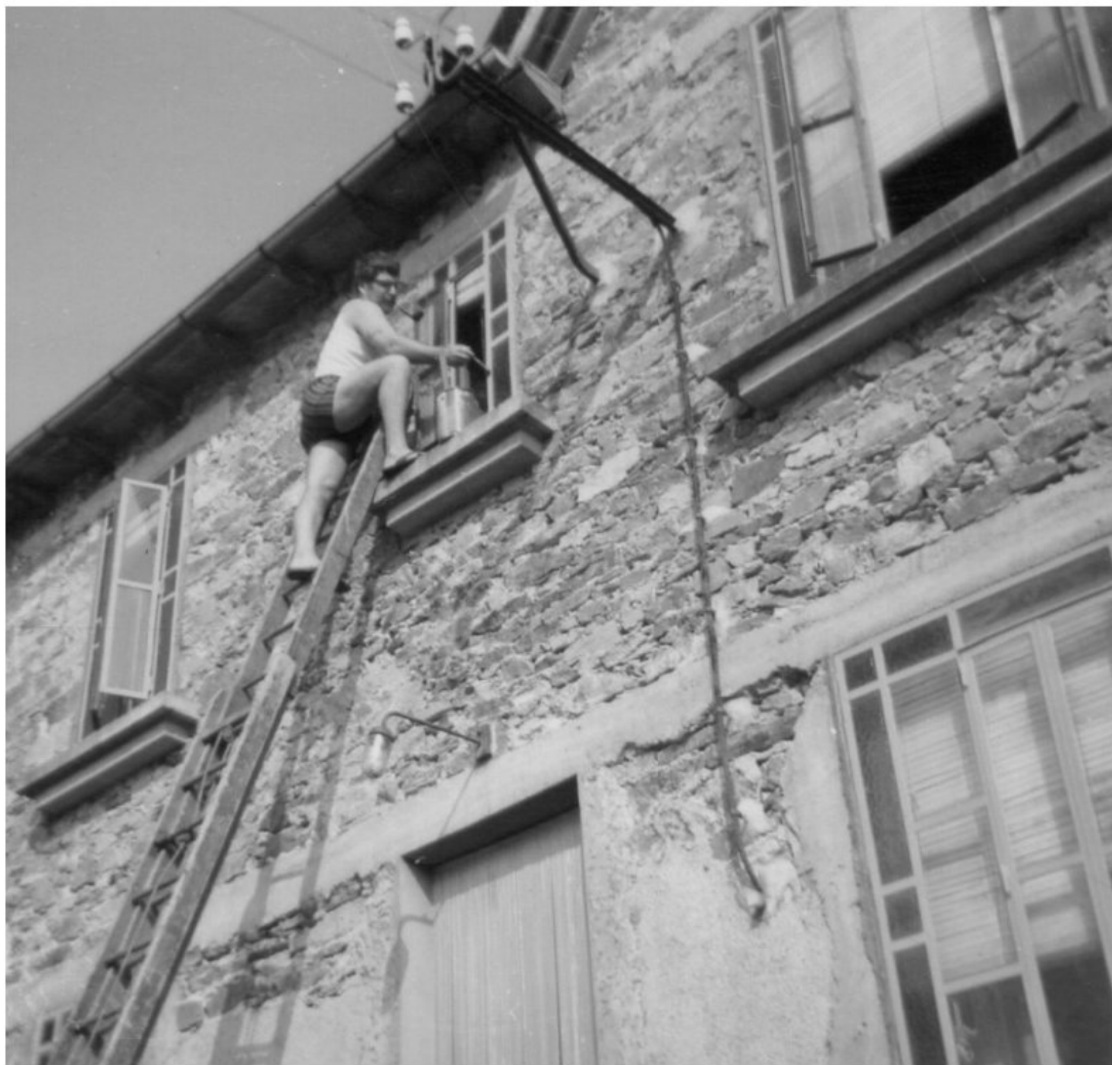
1969 - Travaux maison Jean AZAM - Grascazes de Meljac
