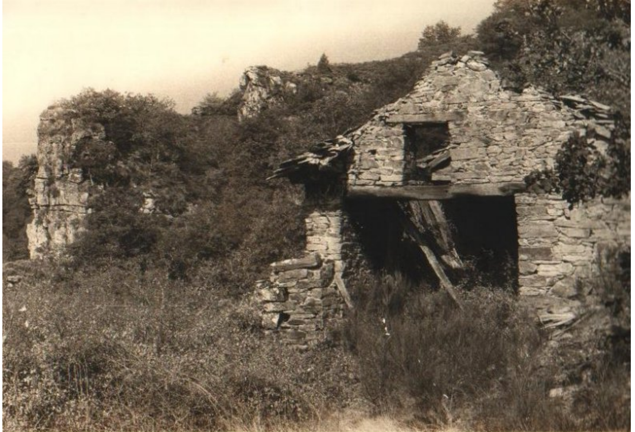
Bastide de JPM avant rénovation
