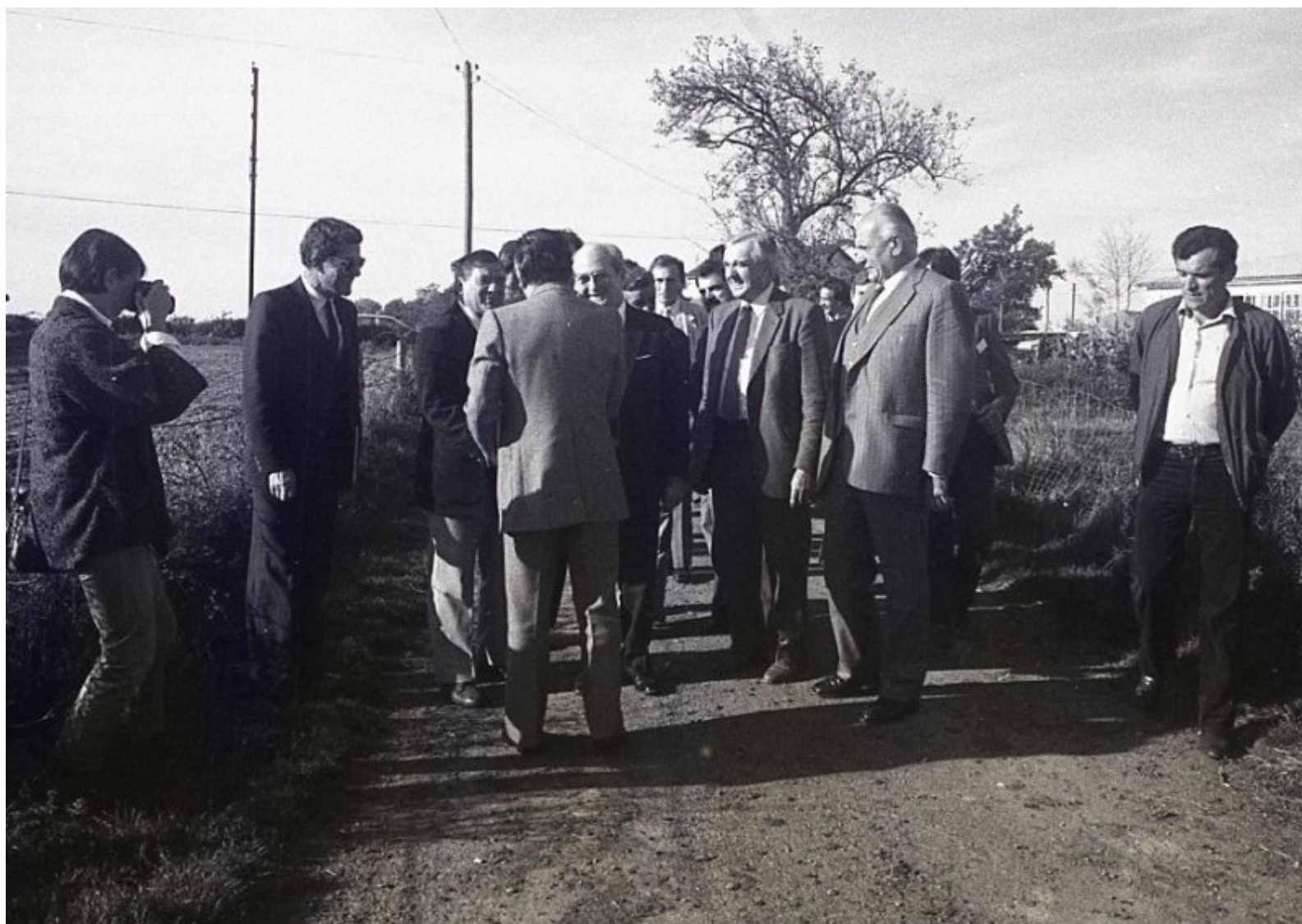
octobre 1984 - Bernard Gaubert (à droite) conduit la visite d'exploitations à Grascazes
